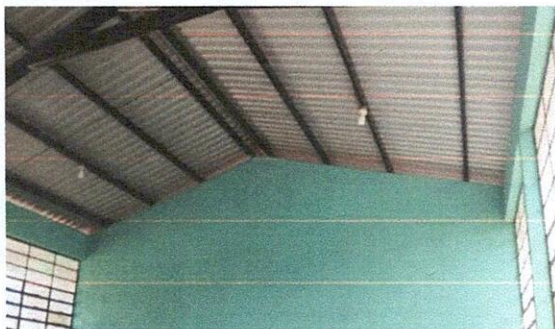
Foto 3: Mejoramiento de iluminacion en aulas
