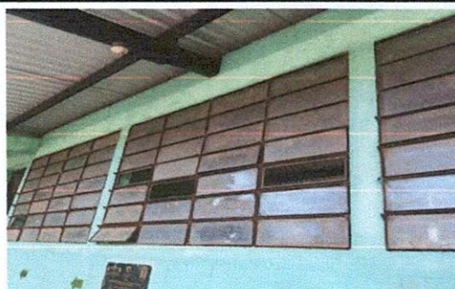
Foto 6: mejoramiento de los bidrios de 3 aulas
