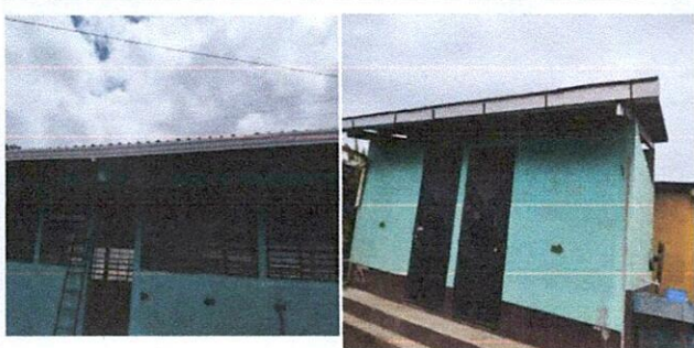
Foto1: Mejoramiento de canales y vajadas de aguas pluviales en sanitario y aulas
